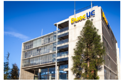
Sede Puente Alto Av. San Carlos 1340, Puente Alto
